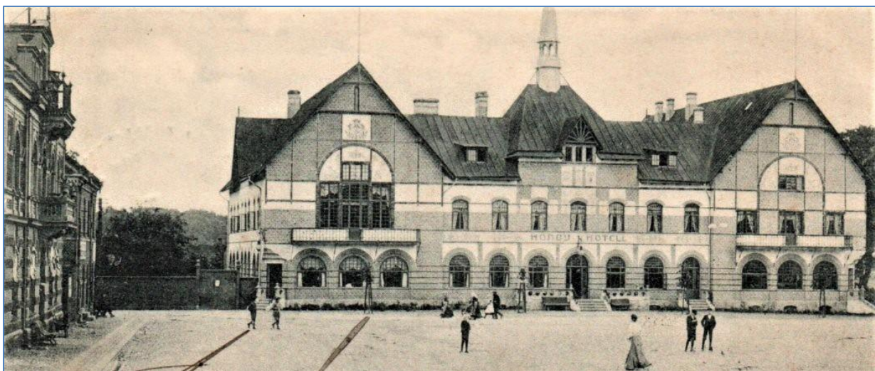
Nya Hörby Hotell strax efter det att det blev färdigbyggt år 1901. Vykort.
