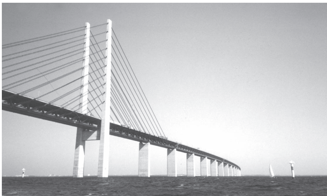
Ett gigantiskt bygge. Ser du gummibåten vid en av pylonerna?
