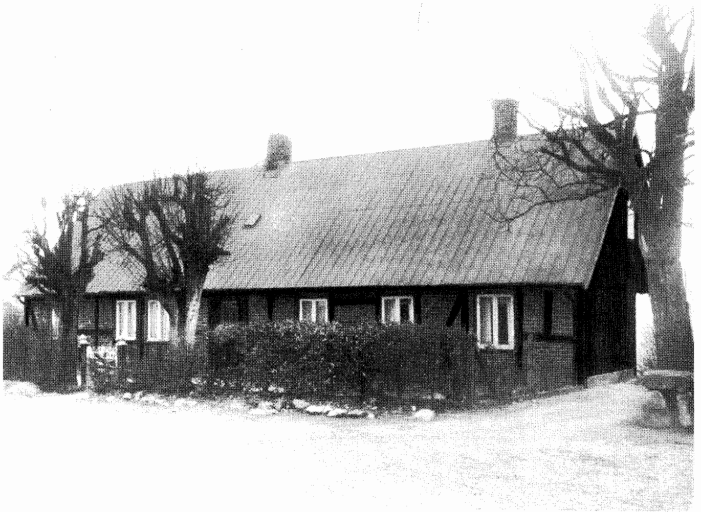
Efter Johanna Herrlins död 1937 togs blommor och växter bort och man företog en renovering mot gatuplanet. Bland annat lades ett orangefärgat plåttak på och korsvirket i väggen målades.
