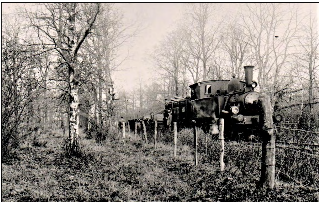
Upptagning av rälsen vid Fulltofta. Tåget på väg mot Hörby. Foto från Gammalstorp.
